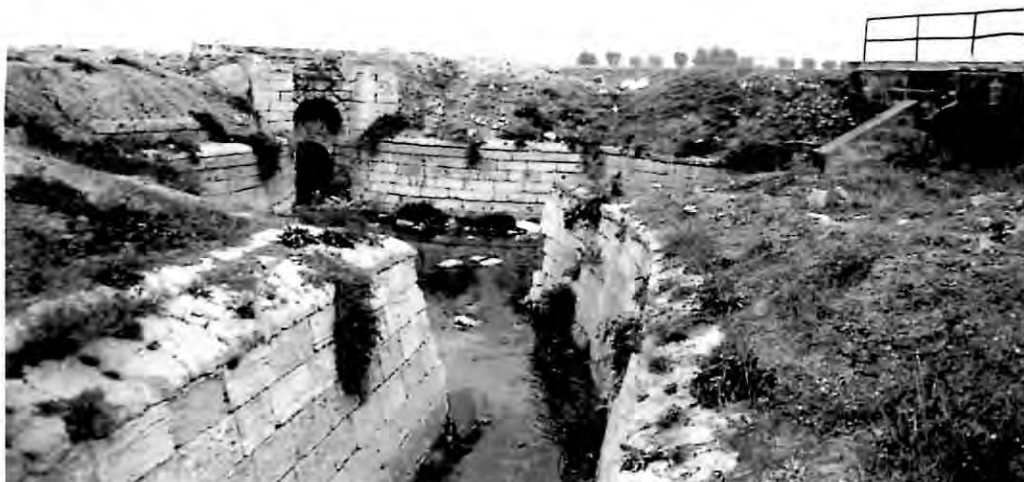
Canale maestro e allacciante sinistro della Salina Grande di Taranto, entrambi confluenti nella galleria sotterranea. (foto Antonio Vincenzo Greco)
